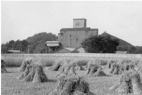
Charbonnage d'Argenteau-Trembleur – Blegny-Trembleur
